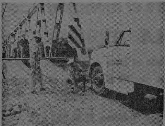
Cuadrillas de carreteras del Departamento de Prevención de Riesgos instalan señales a la entrada del puente sobre el río Pacuare.
